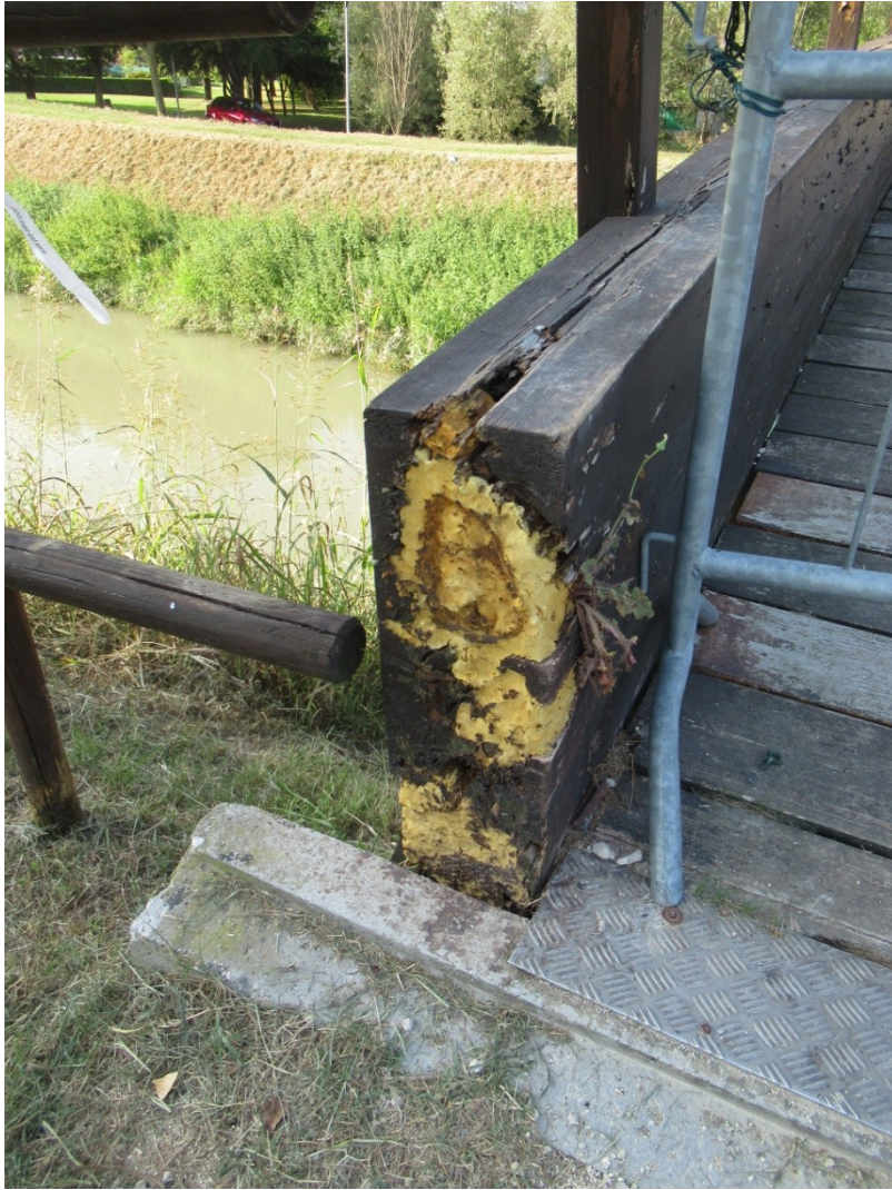
Dettaglio del dissesto della trave in corrispondenza dell'appoggio, che ha determinato la diminuzione della sezione
