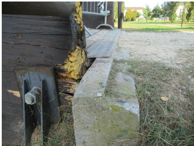
Dettaglio del dissesto della trave in corrispondenza dell'appoggio, che ha determinato la diminuzione della sezione
