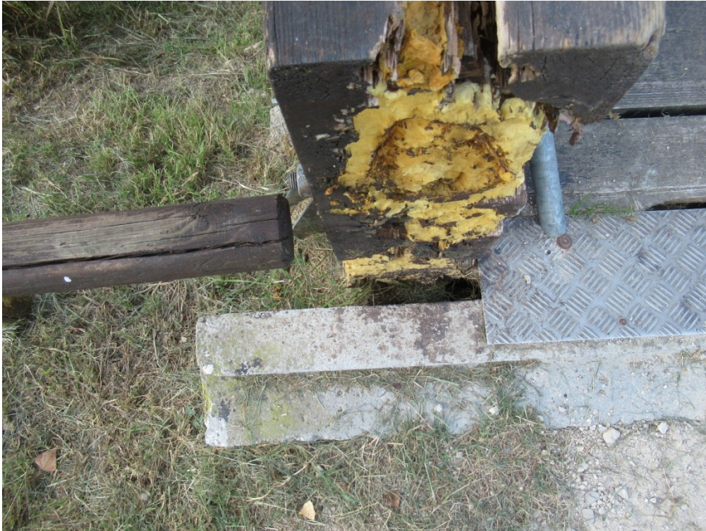
Dettaglio del dissesto della spalla in c.a.
