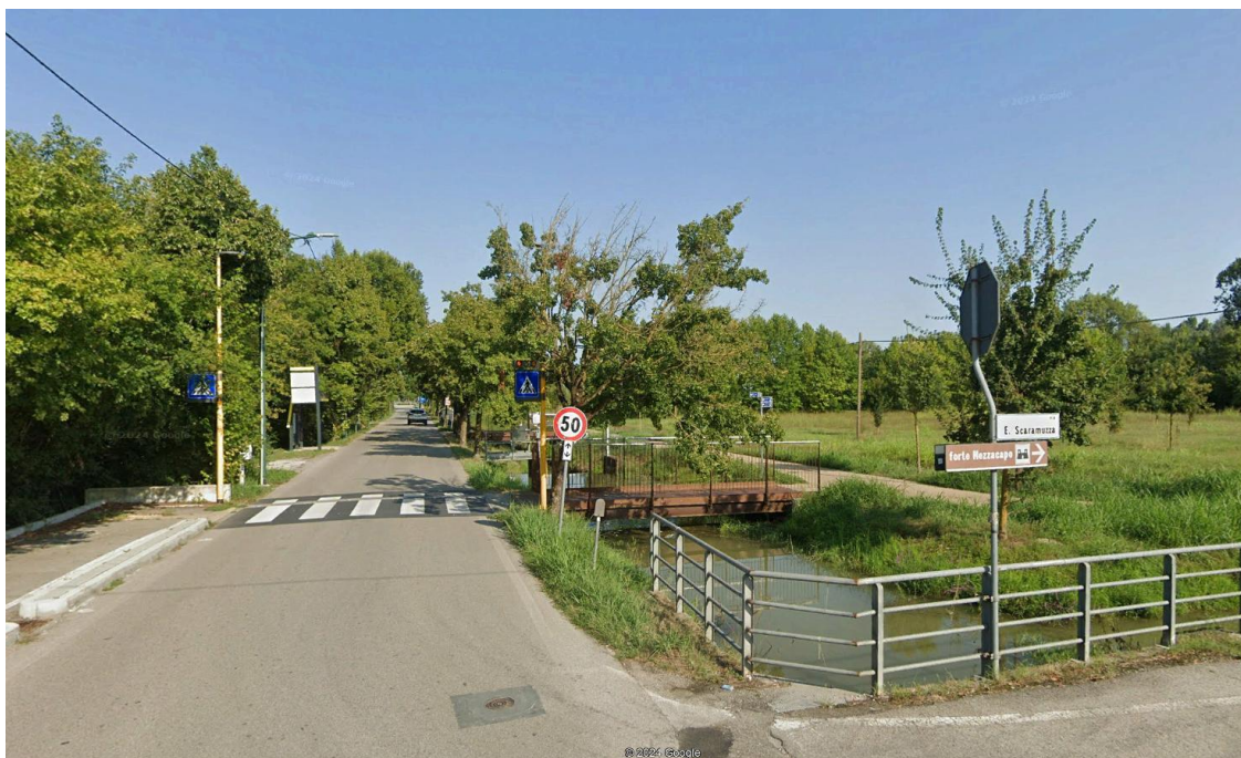
1 - Manufatto 1 da via Gatta
