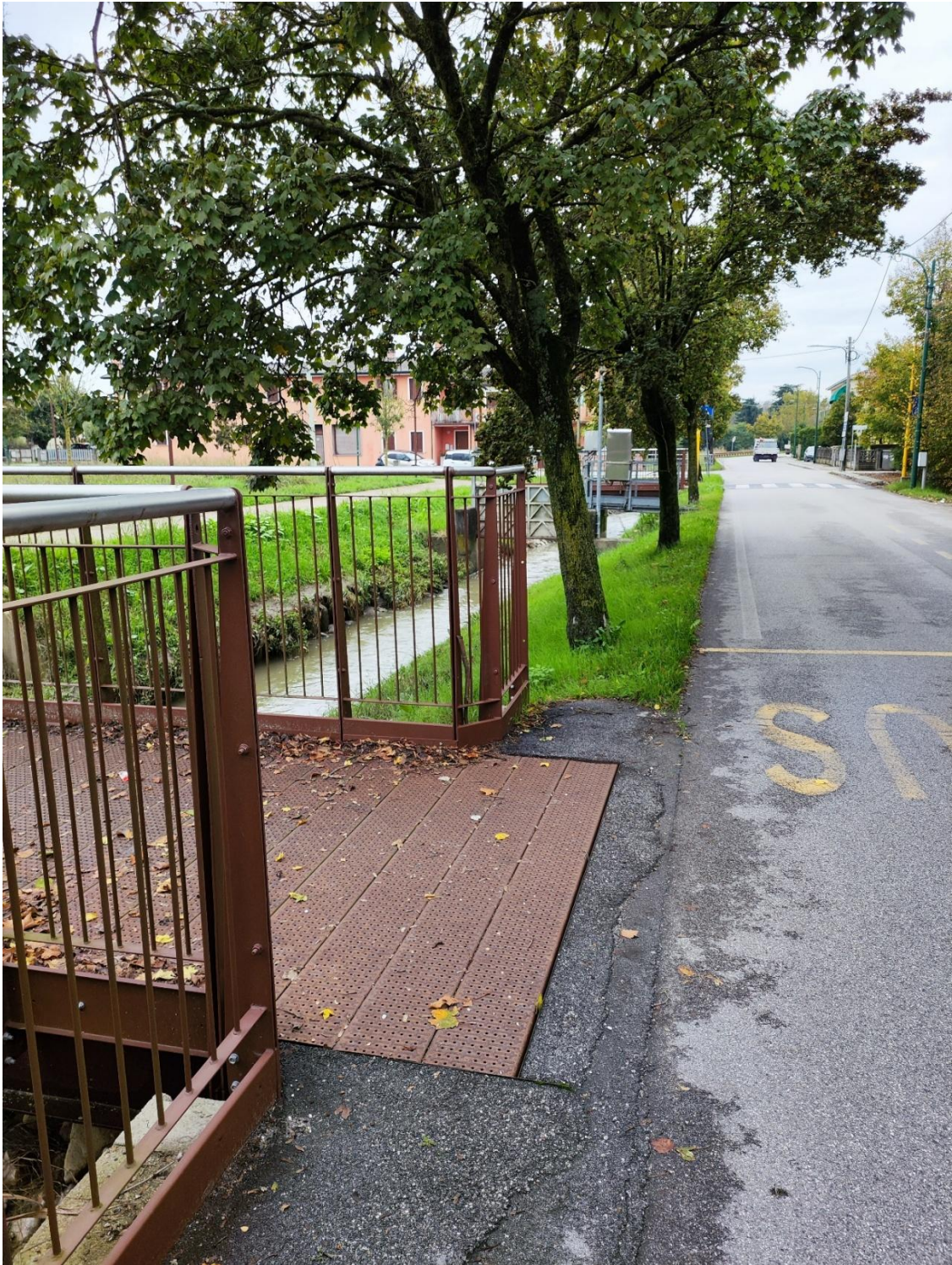
4 - Manufatto 2 particolare sbarco
