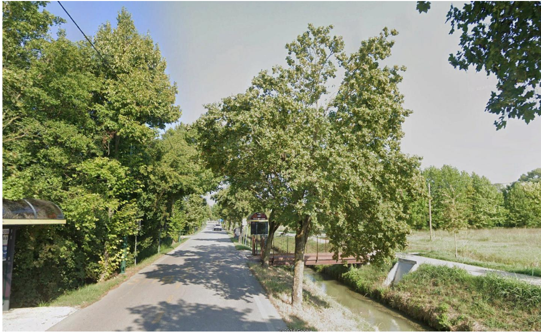
2 - Manufatto 2 da via Gatta
