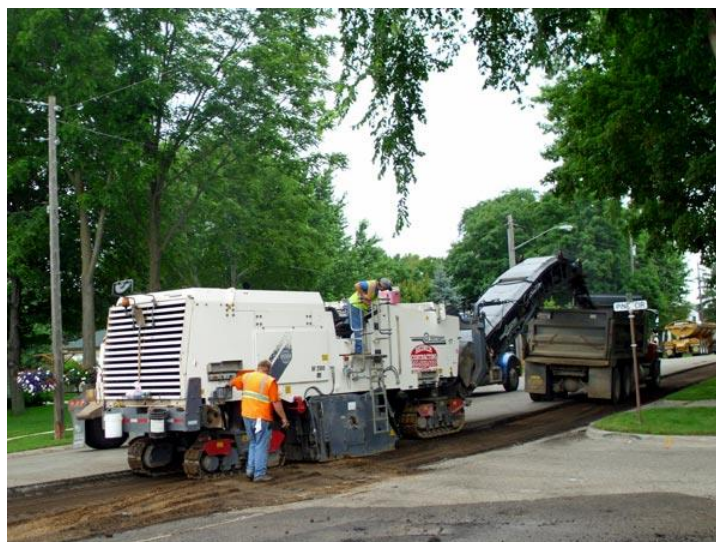
Fig. 6 Lavori di fresatura
