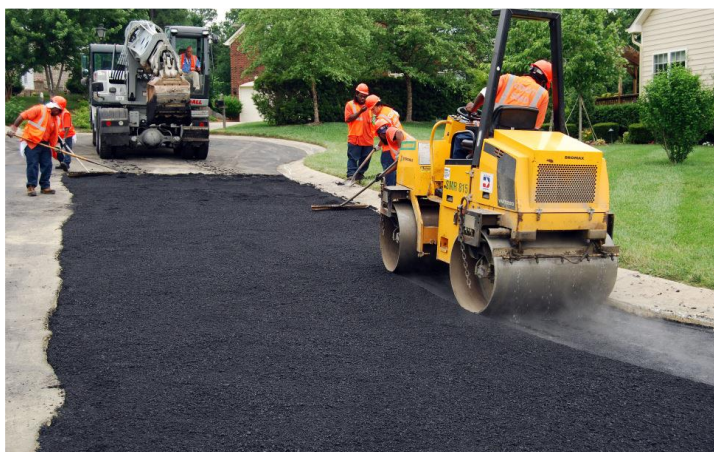
Fig. 8 Stesa manto bituminoso
