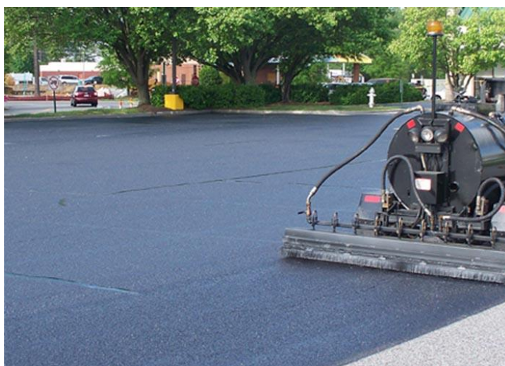
Fig. 7 Spruzzatura emulsione bituminosa
