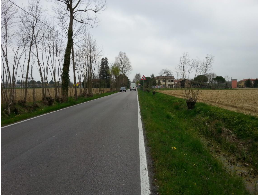
1 – via Ponte Nuovo tratto nord in Comune di Scorzè
