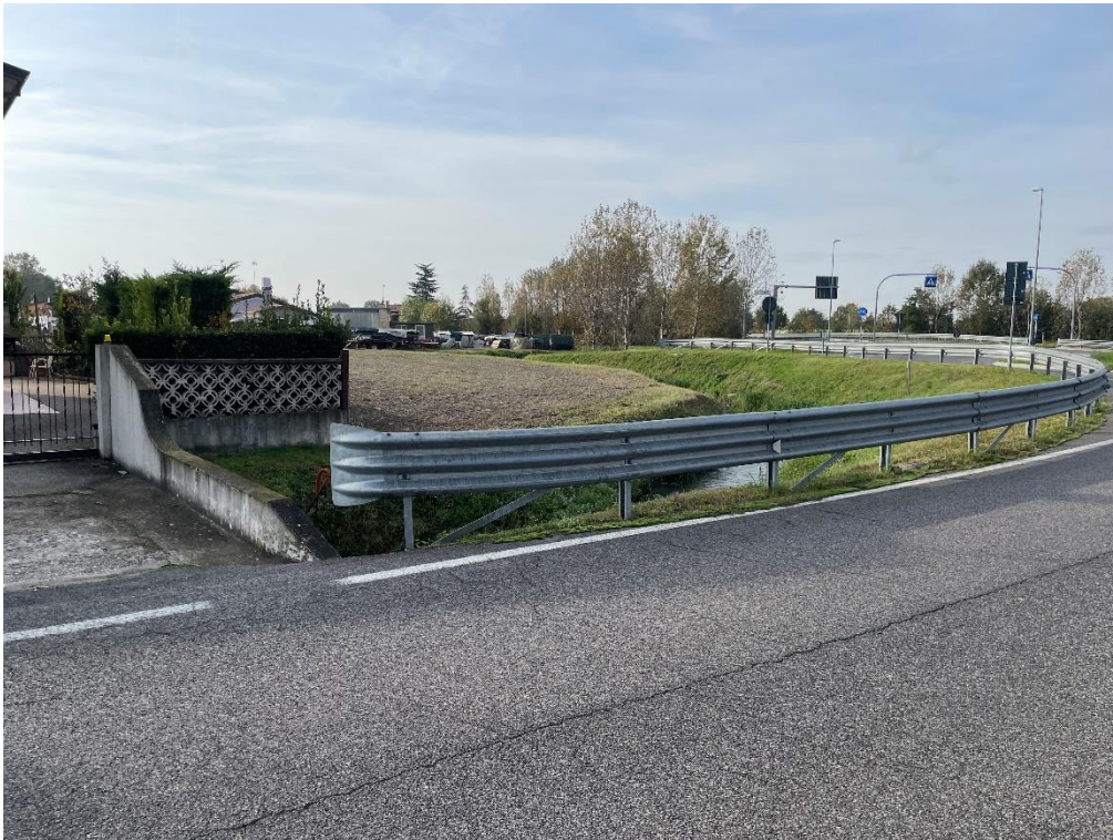
24 – via Morosini: zona nuovo ponte sullo scolo Bazzera
