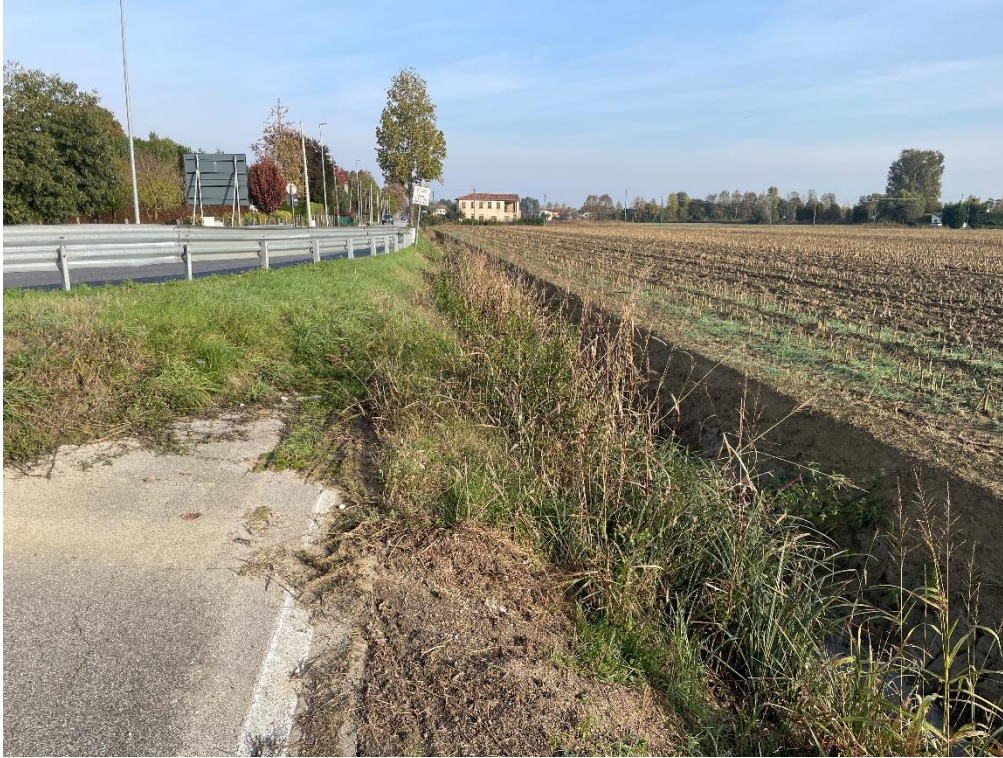
9 - via Ponte Nuovo tratto nord in corrispondenza vecchio sedime stradale abbandonato
