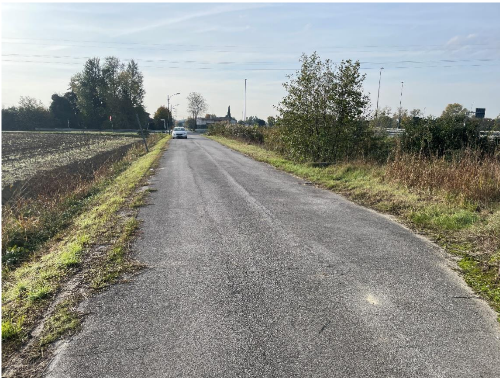
10 - via Ponte Nuovo tratto nord vecchio sedime stradale abbandonato
