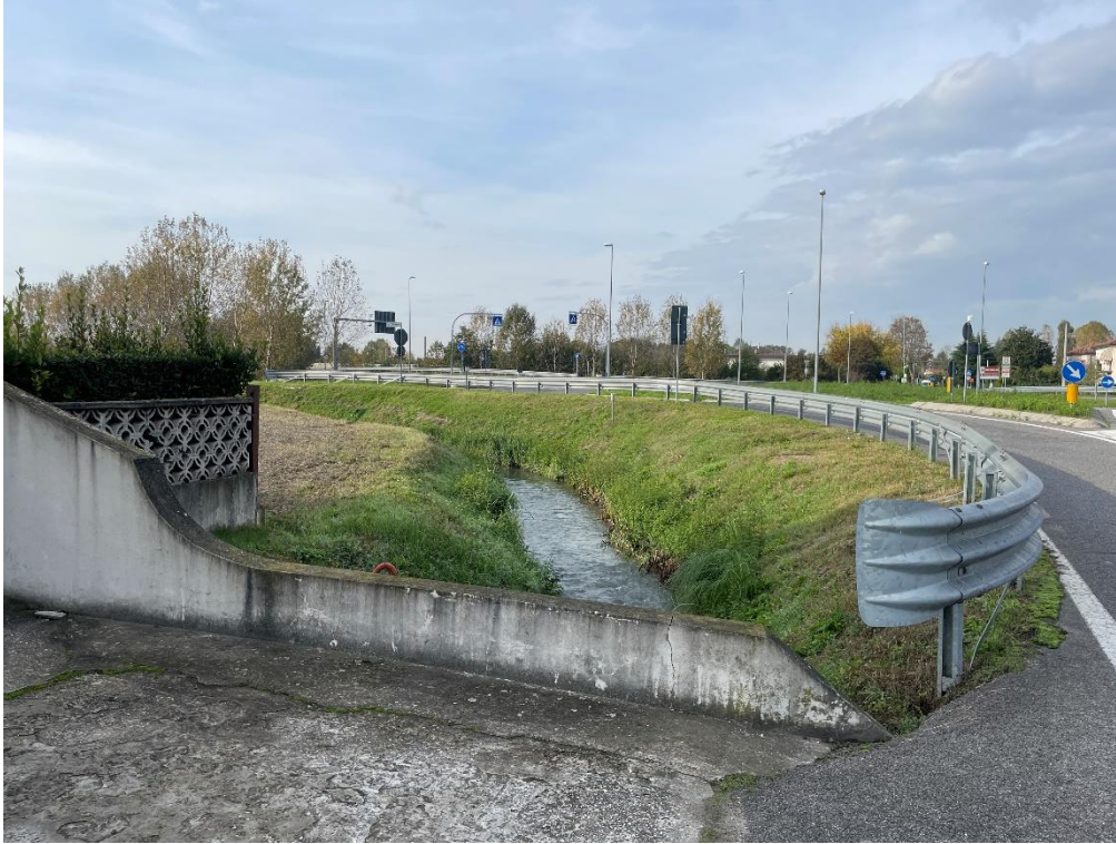
25 - via Morosini: zona nuovo ponte sullo scolo Bazzera
