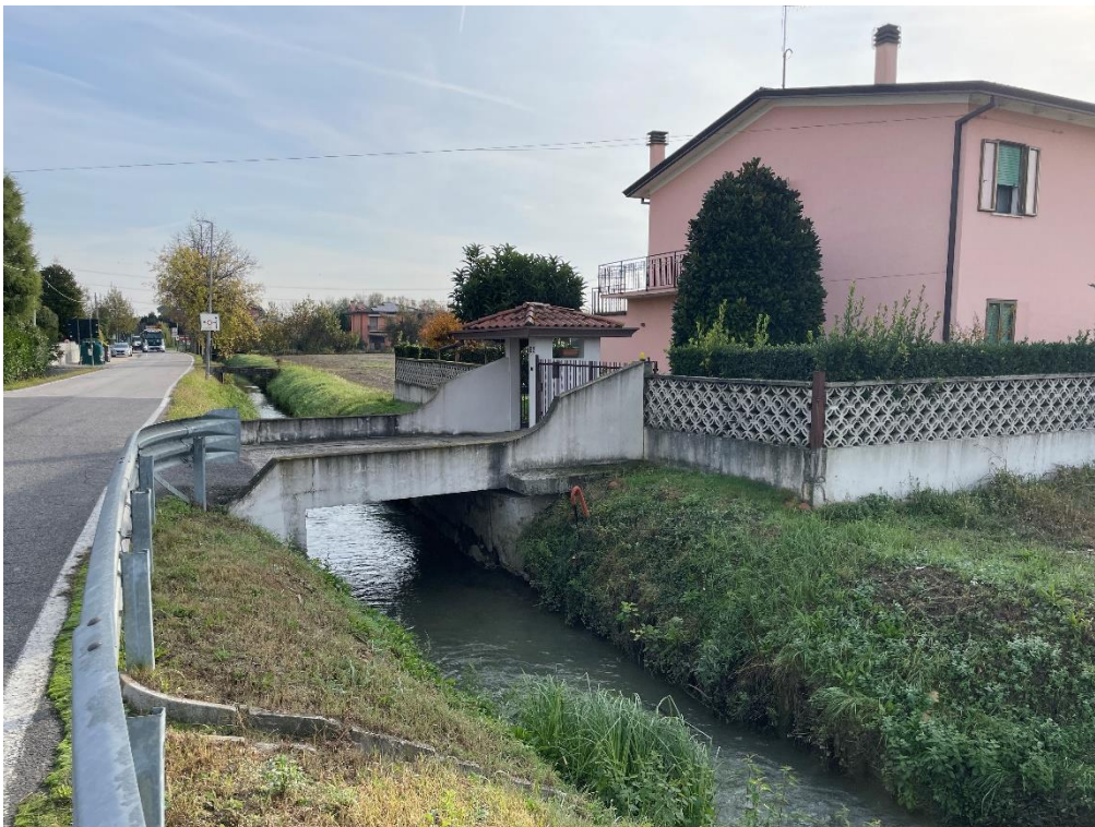
26 - via Morosini: zona nuovo ponte sullo scolo Bazzera
