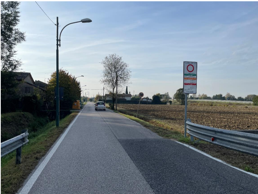
12 - via Ponte Nuovo tratto sud comuni di Venezia e Martellago
