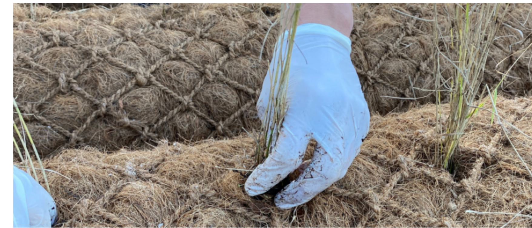
Documentazione esemplificativa di messa a dimora di piante su biorulli
