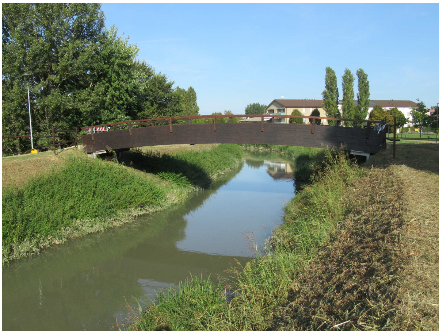
Foto della passerella pedonale esistente
